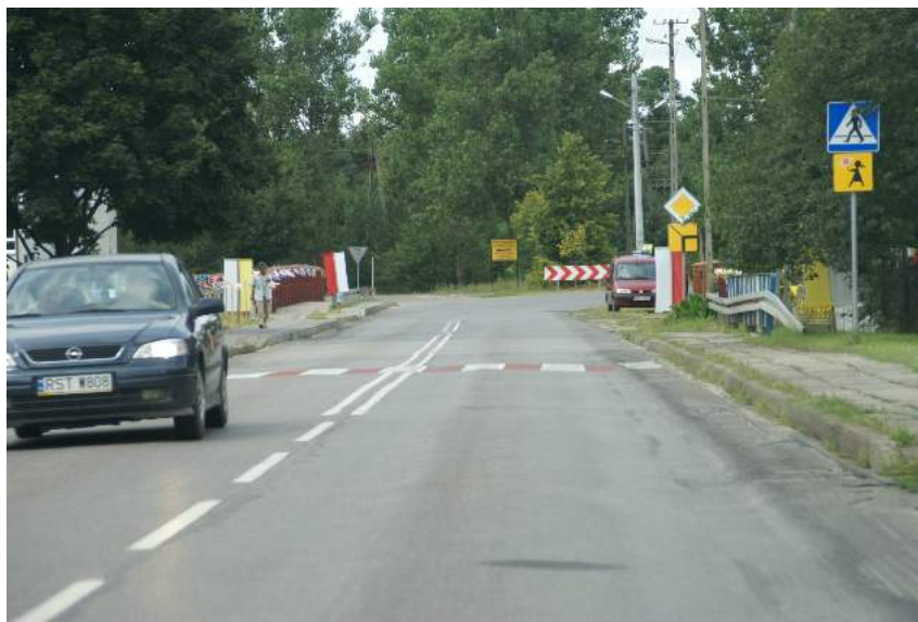
Fot. 9.7. Przykład niebezpiecznego skrzyżowania z załamany kierunkiem pierwszeństwa oraz błędami rozwiązań dla ruchu pieszego (brak ciągłości chodnika, przejście za łukiem poziomym).
