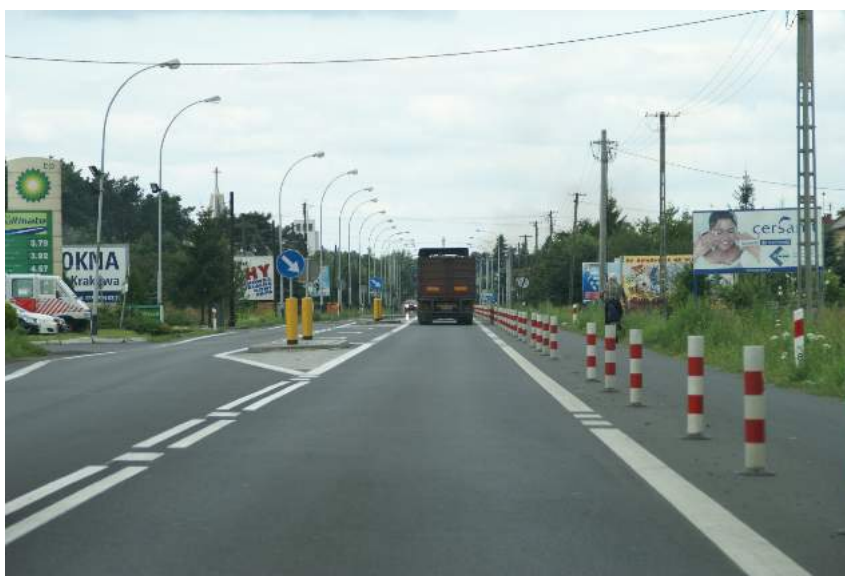
Fot. 9.4. Przykład skutecznej ochrony pieszych i rowerzystów wzdłuż drogi DK 77.
