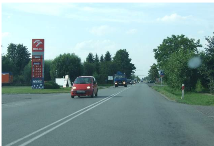
Fot. 9.21. Przykład obsługi stacji paliw bez wydzielonych pasów ruchu mimo dużego natężenia ruchu.
