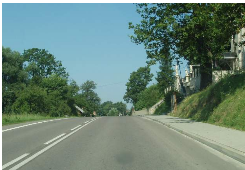
Fot. 9.20. Przykład odcinka na drodze DW 886 z ograniczeniami widoczności powodowanymi przez łuki pionowy w strefie występowaniu ruchu pieszego.
