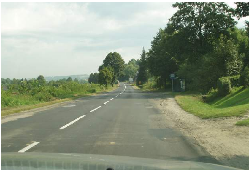
Fot. 9.11. Przykład braku zapewnienia bezpiecznych dojazdów dla pieszych do przystanku autobusowego.
