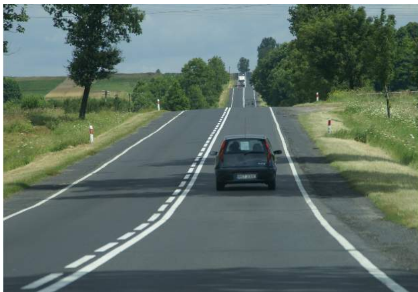
Fot. 9.19. Przykład odcinka na drodze DK 19 z ograniczeniami widoczności powodowanymi przez łuki pionowe.
