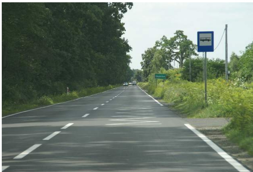
Fot. 9.3. Przykład niedostatecznej ochrony pieszych na dojeździe do przystanku i wzdłuż drogi DK 77.
