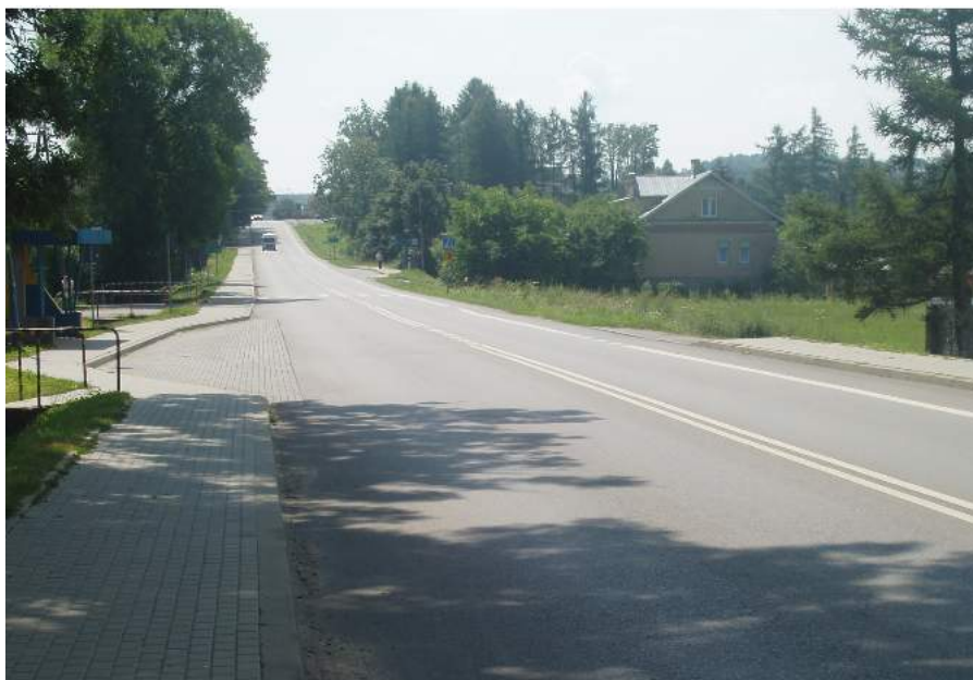
Fot. 9.13. Po prawej stronie chodnik zakończony zbyt wcześnie – w dalszym planie widać zatokę autobusową i przejście dla pieszych bez wyspy azylu. Ukształtowanie drogi umożliwia przejazdy pojazdów przez przejście z dużymi prędkościami (DW 886).
