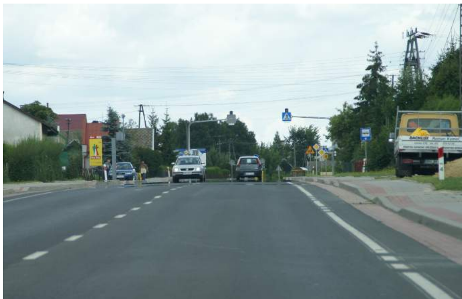
Fot. 9.14. Widok na przejście dla pieszych w rejonie dojścia do szkoły – usytuowanie przystanku przed przejściem może ograniczać widoczność rejonu przejścia, szeroki przekrój drogi i oznakowanie poziome mogą prowokować wyprzedzanie przed przejściem, korzystnym rozwiązaniem jest nadzór prędkości za pomocą fotoradaru oraz wyspa azylu na przejściu i znaki D-6 ponad jezdnią (DK 19).
