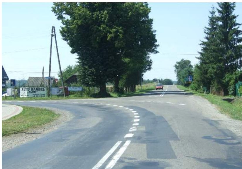
Fot. 9.6. Przykład niekorzystnego rozwiązania skrzyżowania z załamanym kierunkiem pierwszeństwa przejazdu (skrzyżowanie DW 835 z DW 884).
