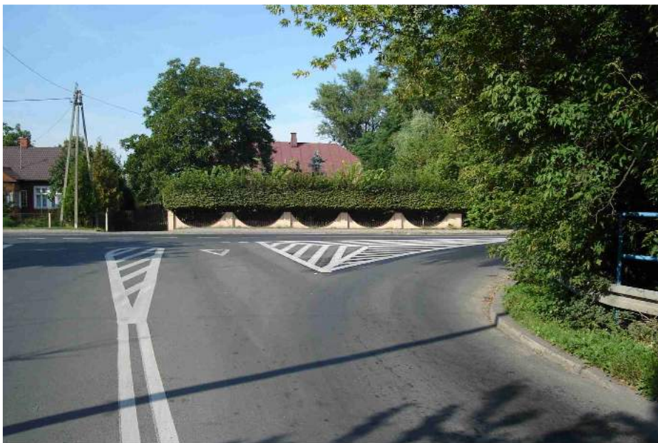
Fot. 9.23. Przykład rozległego skrzyżowania z wyspami malowanymi na wlocie podporządkowanym wydzielającymi dwa pasy ruchu z ryzykiem wzajemnego zasłaniania widoczności przez oczekujące na wlocie pojazdy.
