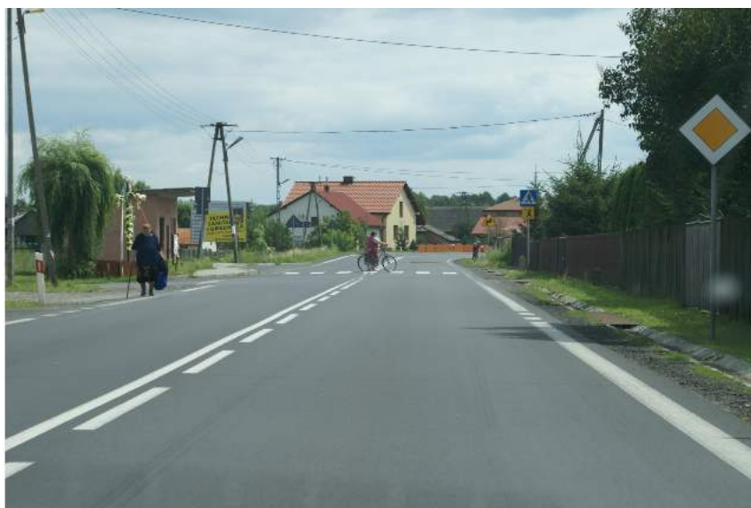
Fot. 9.18. Przykład niewłaściwej lokalizacji przystanku autobusowego i przejścia – złe usytuowanie względem siebie oraz ich lokalizacja w sąsiedztwie łuku poziomego (DW 871).
