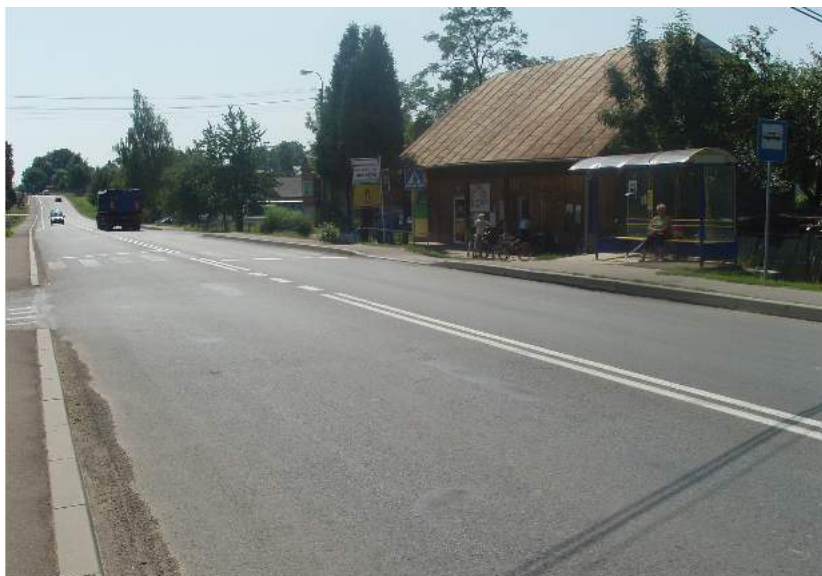
Fot. 9.9. Przykład niewłaściwej lokalizacji przejścia dla pieszych względem przystanku autobusowego, brak wyspy azylu przy ryzyku dużych prędkości pojazdów na dojeździe do przejścia.
