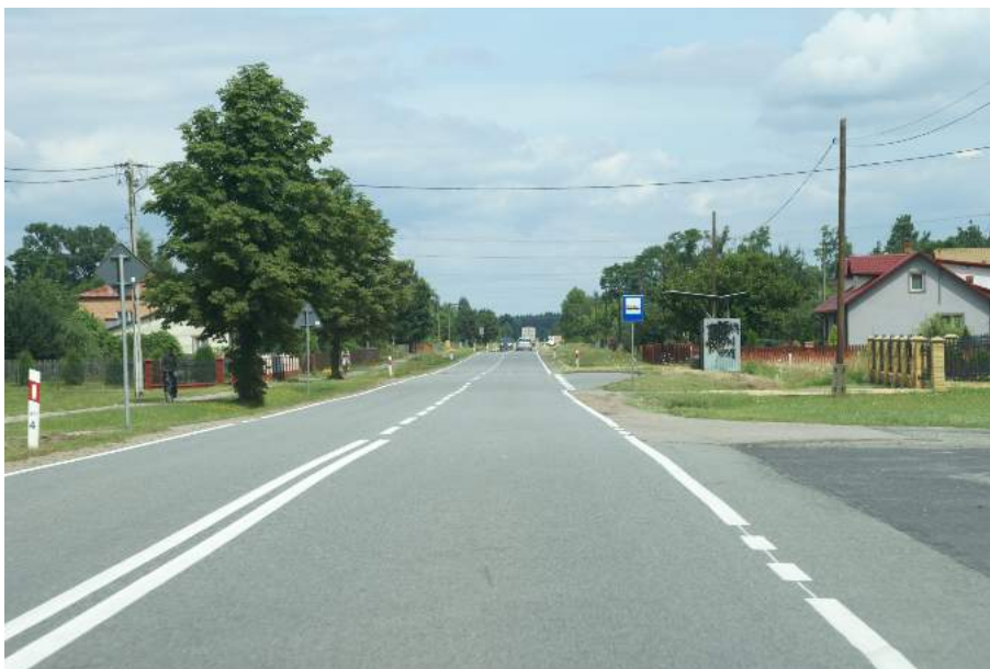
Fot. 9.1. Długie odcinki przejść drogowych przez miejscowości w połączeniu z prostymi odcinkami dróg i szerokim przekrojem zachęcają do rozwijania dużych prędkości.
