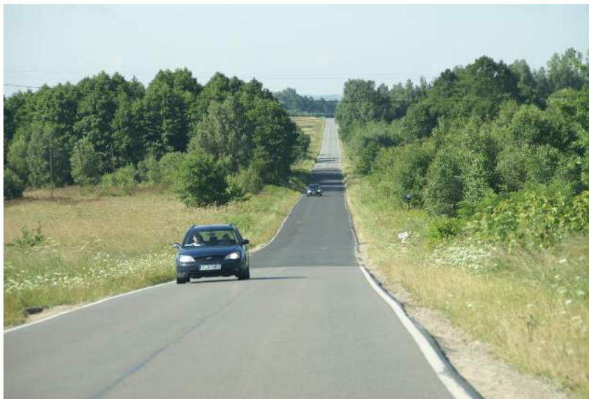
Fot. 9.10. Przykład wąskiego odcinka drogi z niewłaściwie utrzymanymi poboczami umożliwiające rozwijanie dużych prędkości.
