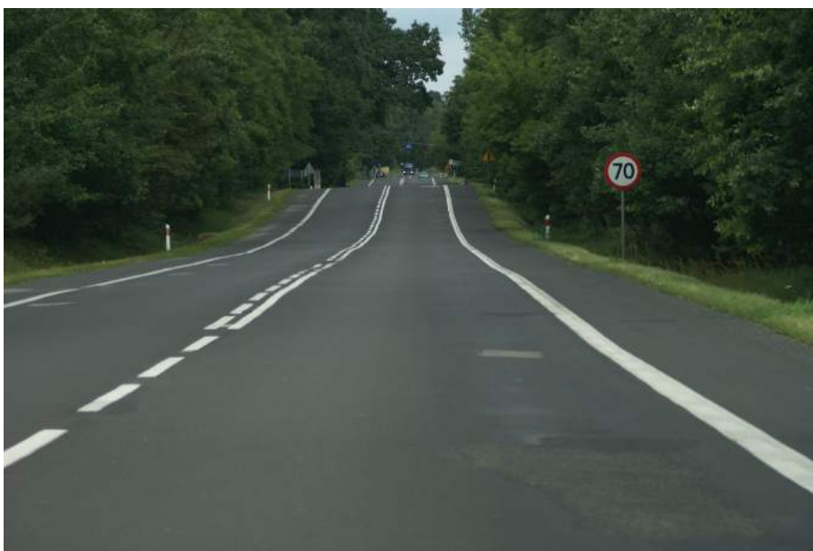
Fot. 9.2. Przykład niekorzystnego ukształtowania wysokościowego sprzyjającego błędom kierujących pojazdami przy podejmowaniu manewrów wyprzedzania.
