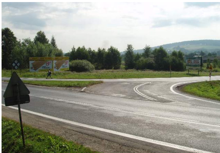
Fot. 9.16. Przykład skrzyżowania z wyspą trójkątną i dwukierunkowymi jezdniami utrudniającymi identyfikację zasad pierwszeństwa przejazdu.
