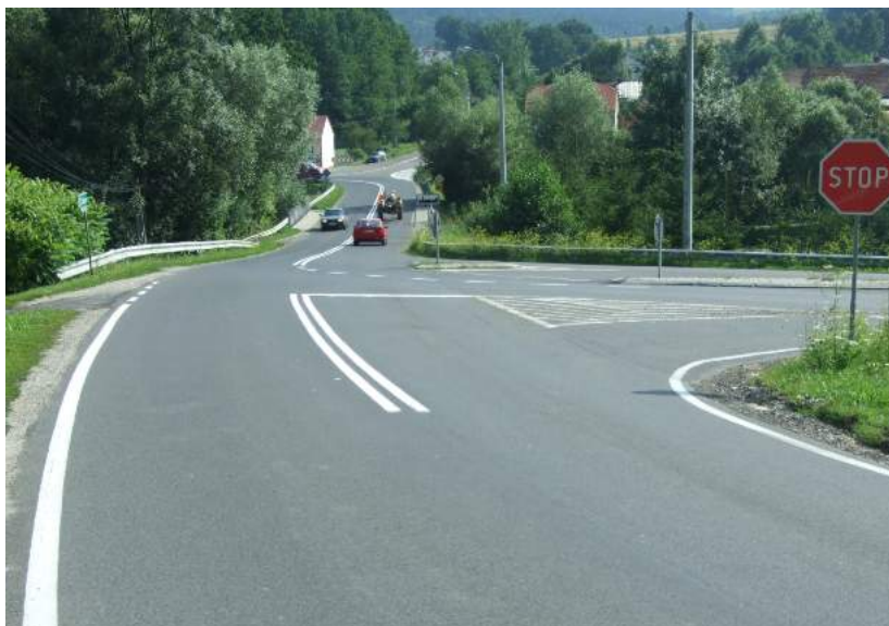
Fot. 9.8. Przykład niedostatecznego sposobu podkreślenia podporządkowania wlotu skrzyżowania (skrzyżowanie DW 878 – DW 877).
