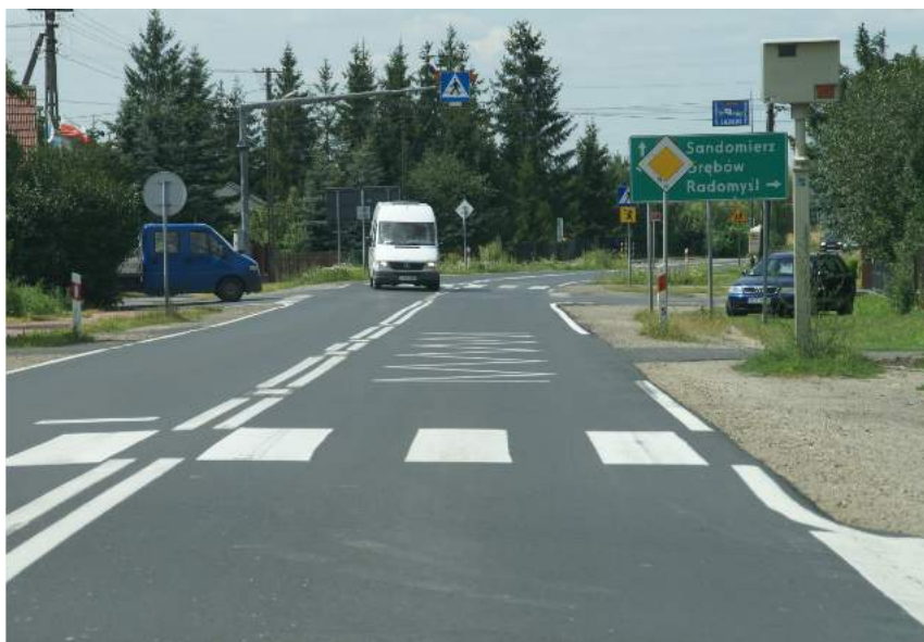
Fot. 9.15. Widok na przejście dla pieszych w rejonie dojścia do szkoły – brak chodników na dojściu do przejścia dla pieszych, przejście na łuku poziomym, brak wyspy azylu, usytuowanie przystanku przed przejściem może ograniczać widoczność rejonu przejścia, korzystnym rozwiązaniem jest nadzór prędkości za pomocą fotoradaru oraz dodatkowe oznakowanie znakami D-6 ponad jezdnią (DK 77).
