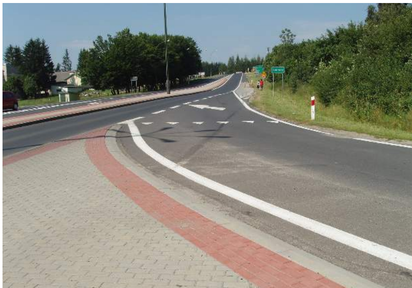
Fot. 9.17. Przykład niekorzystnego, pod złym kątem włączenia z wlotu podporządkowanego na skrzyżowaniu dróg DK 28 z DW 886.
